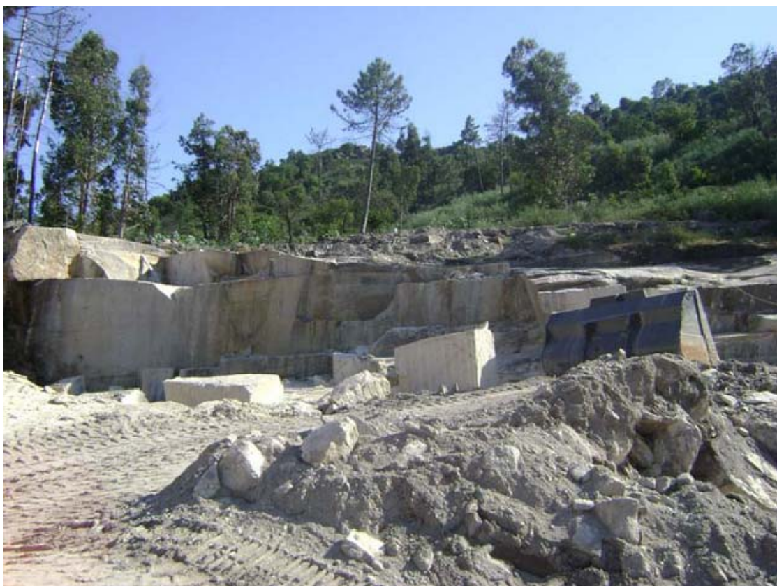
Fotografia 1: Vista geral da frente de desmonte e zona envolvente
